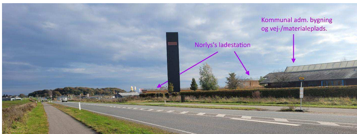
Pylonen er placeret på kommunens vej- og materialeplads 20 meter fra kommunens administrationsbygning og direkte op til Norlys' ladestation, som er under opførelse.
